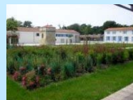
hébergement collectif en chambre de 4 à 6 personnes
